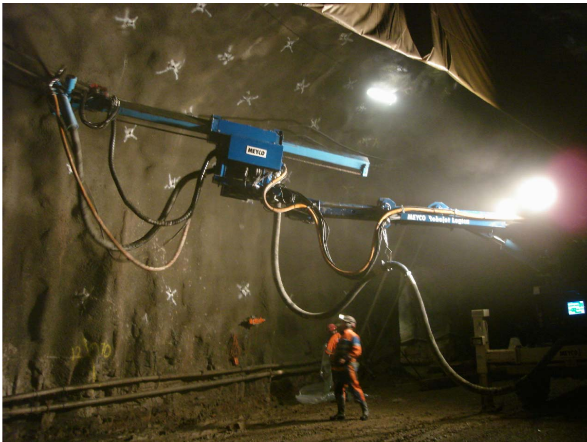
Figur 3. Bilden är tagen vid en av provsprutningarna och visar sprutning på bultbrickor. Detta arbete kan inte utföras med hjälp av scanning.
